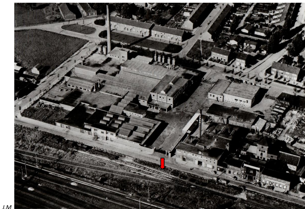
Luchtopname van de twee laagspoorlijnen ( zie pijl ) aan “De Put” die in 1972 zijn opgebroken, met op de voorgrond het hoogspoor. Aan dit laagspoor lagen diverse bedrijven die van het spoor gebruik maakten. Zo lag er het vleesverwerkend bedrijf St. – Antonius van de familie Meewis later werd dit Limco Weert. Dit bedrijf had als enige in Weert eigen spoorwagens met de naam van het bedrijf op de zijkanten. Ik zie de medewerkers nog zo voor me, de lading handmatig losse in de witte overalls met witte mutskappen op. Ook lagen er de bekende Weerter cafés van Taatje Coenen en van de familie Ramaekers. Verdere woonde er de families v.d. Voorst en Toon op ’t Rood met als bijnaam ‘de Plek’. In de jaren 40 was er ook het bedrijf van de familie Muijs gevestigd.
