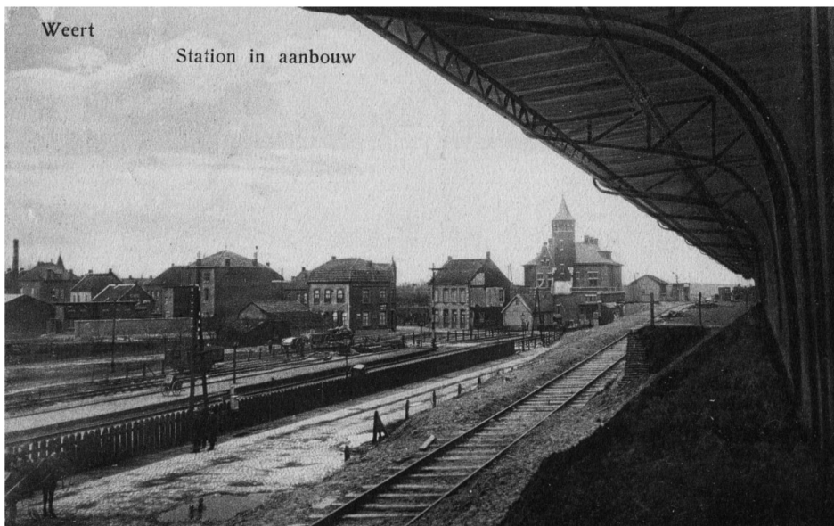
Het nieuw station van Weert in aanbouw. Links zien we het laagspoor van de IJzeren Rijn, met op de achtergrond het stationsgebouw in 1913.
