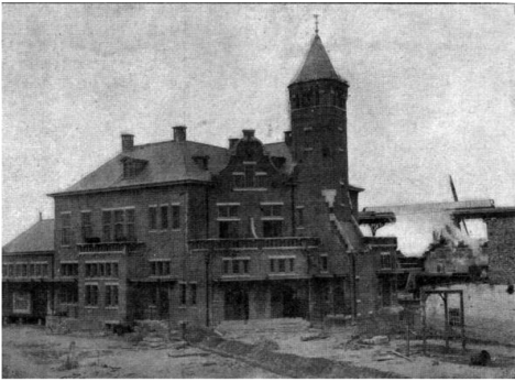
Het tweede station in aanbouw in 1913
